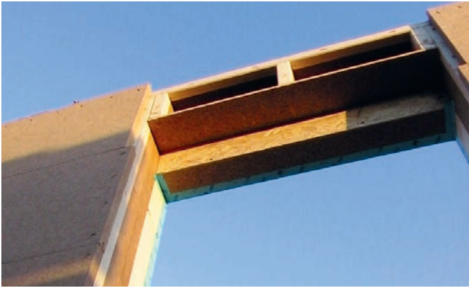
Abb. 2: Eine Holzrahmenbauwand mit äußerer Holzfaserdämmplatte als Putzträger bei der Montage. Foto: Gerrit Horn
