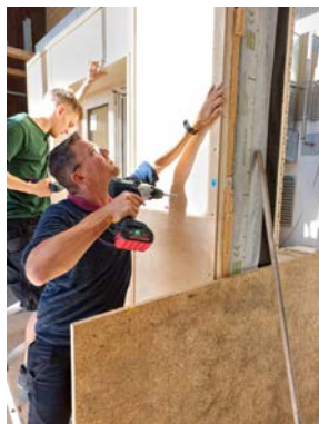
Befestigen Innenbekleidung (2)
