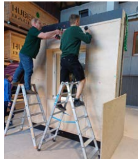
Wegschrauben Abdeckleisten
