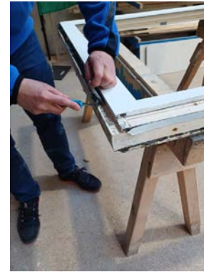
Ablösen Fensterdichtbänder
