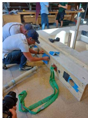
Verschließen Einblasöffnung
