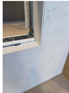
Freigelegte Gipsfaserplatte
