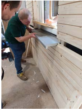
Einbau Fensterblech
