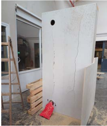
Plattenbruch beim Einbringen der Strohdämmung in dichte Gefache ohne Stützlattungen
