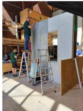
Einbau Dampfbremse (1)
