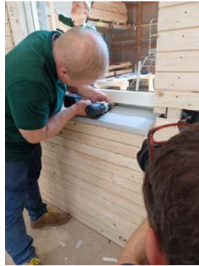
Befestigung Fensterblech
