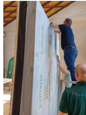
Einbau Dampfbremse (2)
