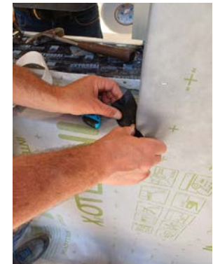
Einbau Dampfbremse (4)
