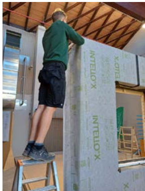
Ausdecken Dampfbremse (1)
