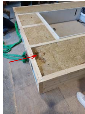
Dämmfehlstelle Strohdämmung
