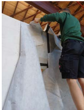
Ausdecken Dampfbremse (2)
