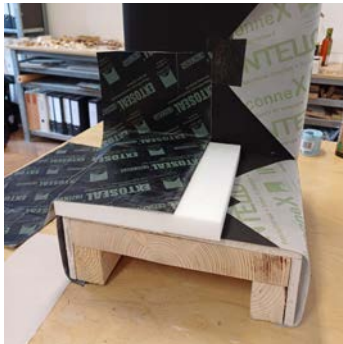
Verlegen Folienschürze mit seitlichem Hochzug
