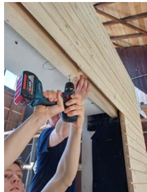
Einbau Latte Fensterlaibung
