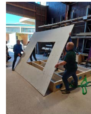
Abheben 2. Gipsfaserplatte
