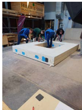
Aufschrauben Gipsfaserplatte
