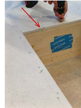
Kl. Fehlstelle Gipsfaserplatte
