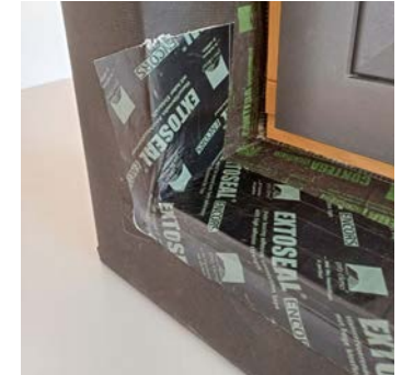
Anschluss Fensterdichtband auf der Folienschürze. Zustand vor dem Einbringen der Dichtecke.
