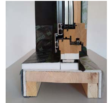
Schnittansicht Fensteranschluss ohne Innen- und Außenbekleidung
