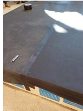
Stoßsicherung mit Klebeband
