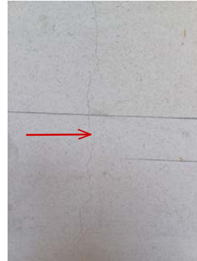
Plattenbruch Strohdämmung
