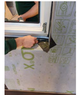
Aufschneiden Fensterdichtung
