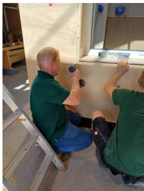
Befestigung Innenbekleidung (1)
