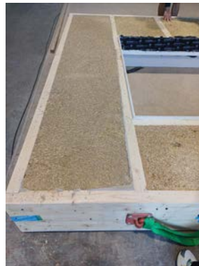
Freigelegte Strohdämmung
