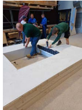
Demontage Gipsfaserplatte
