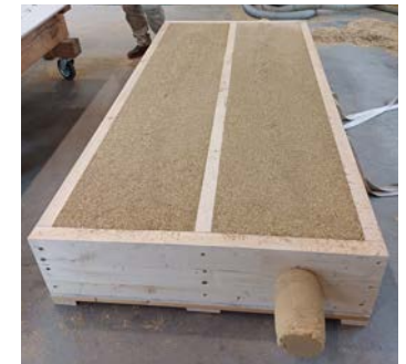
Offenes Gefach mit perfekt eingebrachter Strohdämmung
