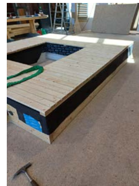
Fertig montierte Holzschalung
