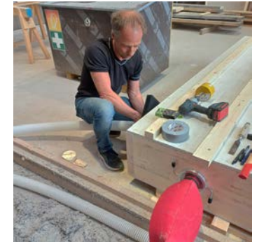
Liegendes Einblasen der Strohdämmung mit Schlauch
