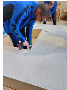
Aufschrauben Gipsfaserplatte
