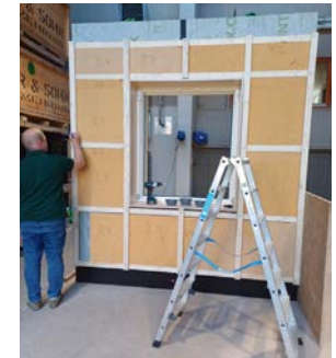
Freigelegte Installationsebene
