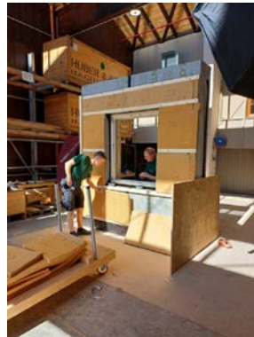
Ausdämmung Inst.-Ebene
