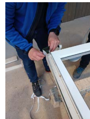
Eckschleife Fensterdichtband
