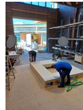
Demontage 2. Gipsfaserplatte
