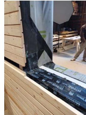
Freigelegter Fensteranschluss
