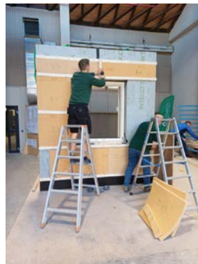
Ausbau Dämmmatten (1)
