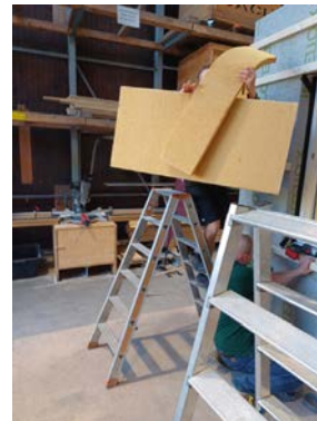
Ausbau Dämmmatten (2)
