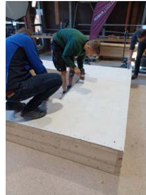
Verschrauben 2. Gipsfaserplatte
