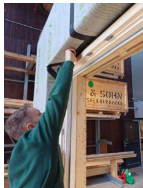
Aufschneiden Fensterdichtung
