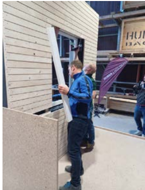
Ausbau Überdämmung Fenster
