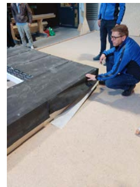
Abnahme Fassadenschutzbahn
