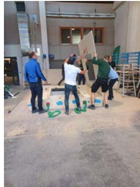
Auflegen 2. Gipsfaserplatte
