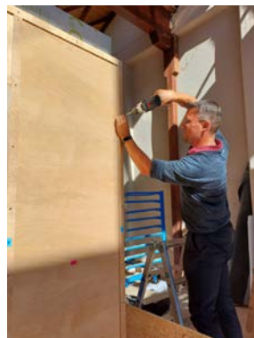
Aufschrauben Abdeckleisten
