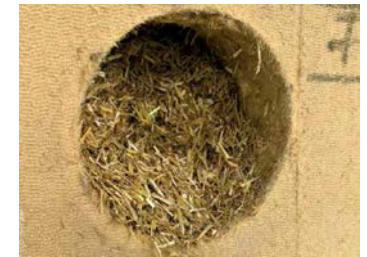
Stroh-Einblasdämmung
