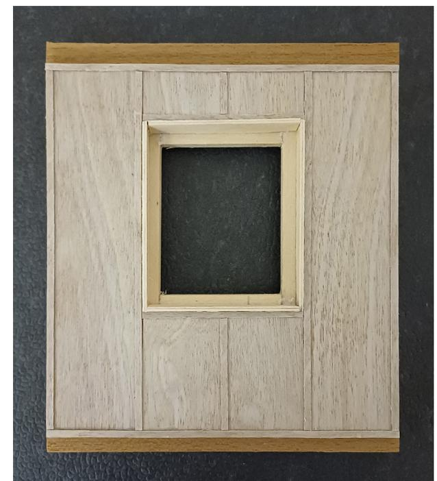
Zeichnung 10: Innenansicht Bekleidung - Fensteranschluss (Multiplexplatten mit Deckleisten)
